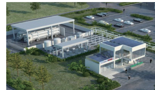
水素燃料電池による実証試験
