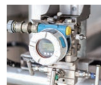
水道・ガスメーター
