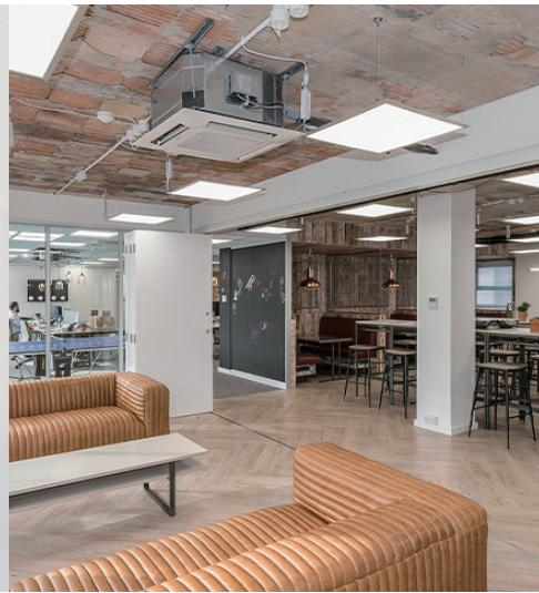
kebutuhan untuk memasang PCB 3-arah dan kit katup solenoid untuk setiap unit dalam ruangan. Ini juga menyederhanakan dan mengurangi biaya dan waktu dalam proses instalasi dan perancangan. Untuk pengguna akhir, keuntungannya adalah setiap kaset dapat dikontrol secara individual, memungkinkan satu kaset berada dalam mode pendinginan sementara yang lain dalam mode pemanasan.
