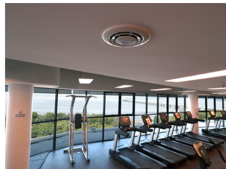
Bộ phát nanoe™ X gắn trần air-e được lắp đặt trong các phòng gym của trường.
