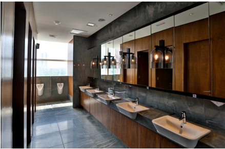
เครื่องผลิต nanoe™ X Air-e ที่ติดตั้งในห้องน้ำที่โรงแรม New World Hotel Petaling Jaya
