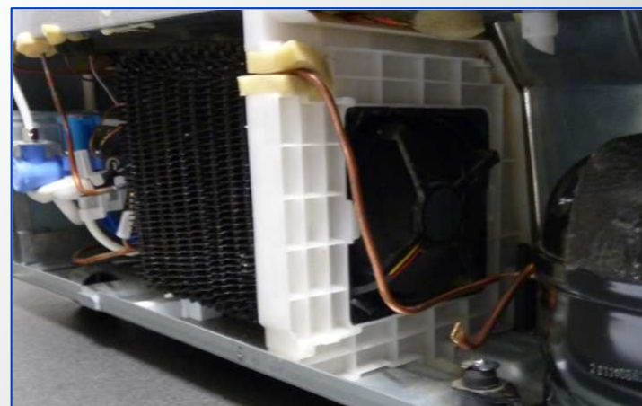
Ventilateur secteur compartiment compresseur commande entre 9 V et 11.5V DC
