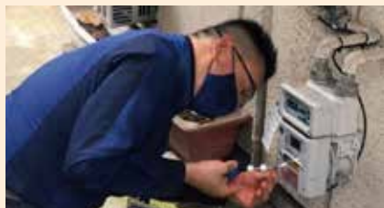
専門知識を持つ社員にて、無線機の 設置と通信確認を行います。
