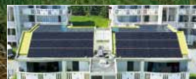
市営住宅40棟202戸にHIT®太陽光パネルを設置
