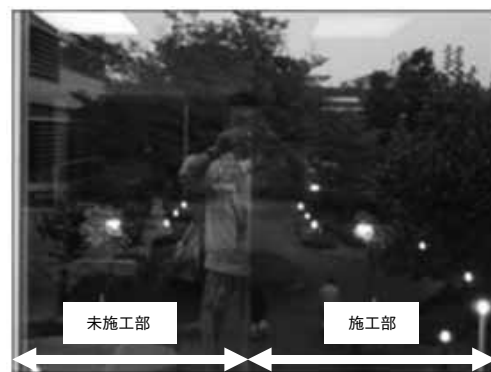
図8 展望ガラスをイメージした施工例
