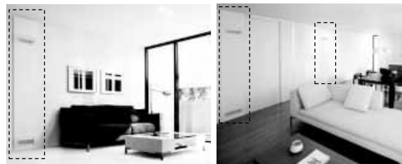
図1 壁パネル型空気循環装置の設置例
