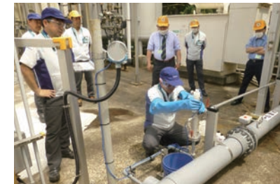
現場確認によるリスクアセスメント
