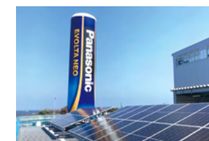
エボルタNEOラッピングされた水素タンク (二色の浜工場)
